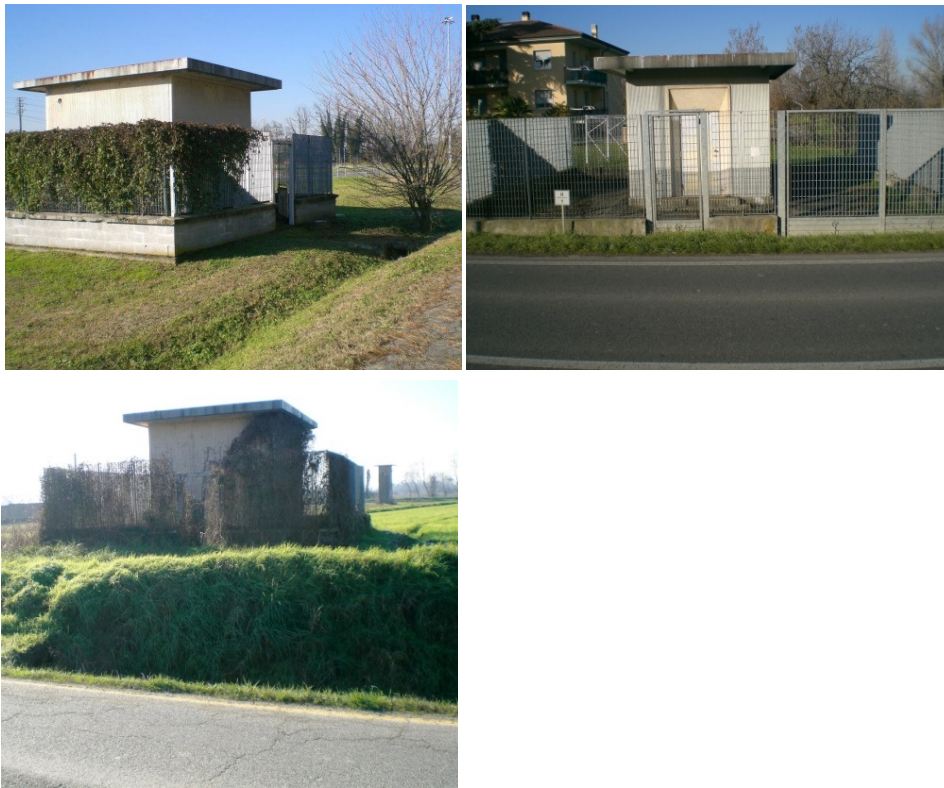
Esempio di edifici - mini centrali - ubicati su tutta la rete nazionale di strade statali e provinciali
